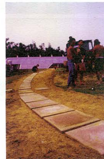
圖4 建築繁殖場學生施作入口步道路徑（圖片來源：建築繁殖場）
